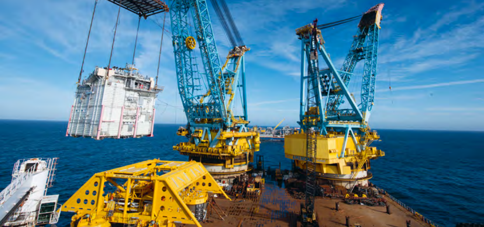
Installasjon av subseamodul på Åsgard i Norskehavet. Foto: Øyvind Hagen/Statoil.
