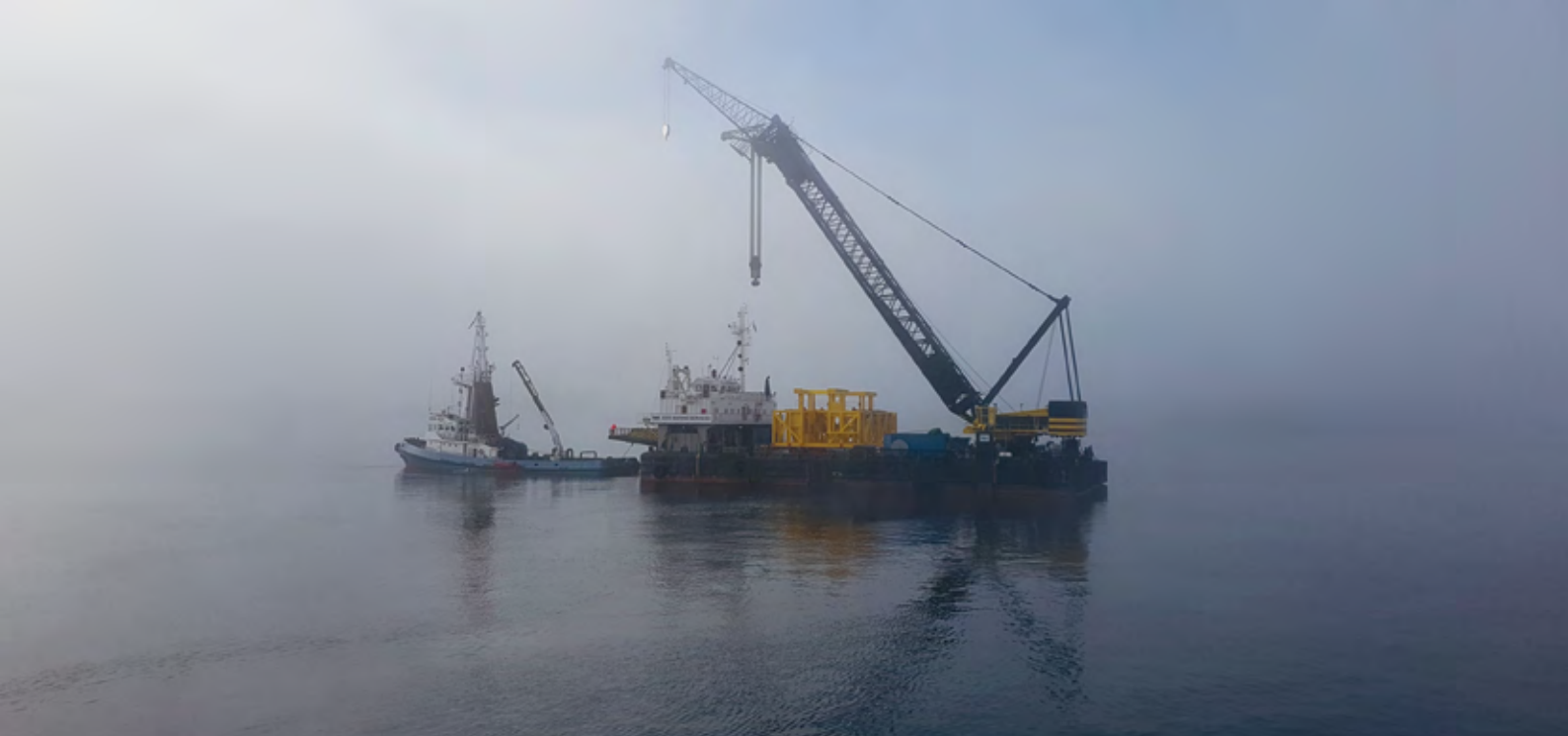
Pumpestasjon og havbunnsramme fra Radøygruppen og OneSubsea er levert til Shell på verdens dypeste felt på 2900 meter i Mexicogulfen. Foto: Shell
